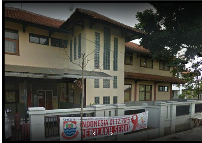
Gambar 27. Bangunan Puskesmas Padasuka
