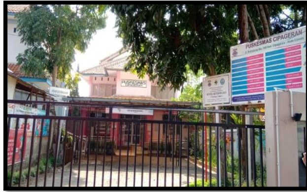
Gambar 31. Bangunan Puskesmas Cimahi Pageran
