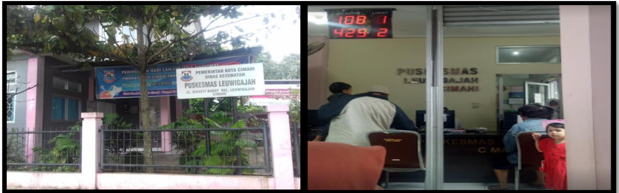
Gambar 19. Bangunan Puskesmas Leuwigajah
