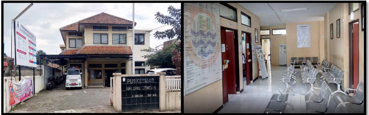
Gambar 21. Bangunan Puskesmas Melong Tengah
