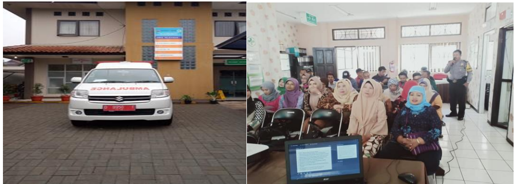
Gambar 17. Bangunan Puskesmas Cibeber
