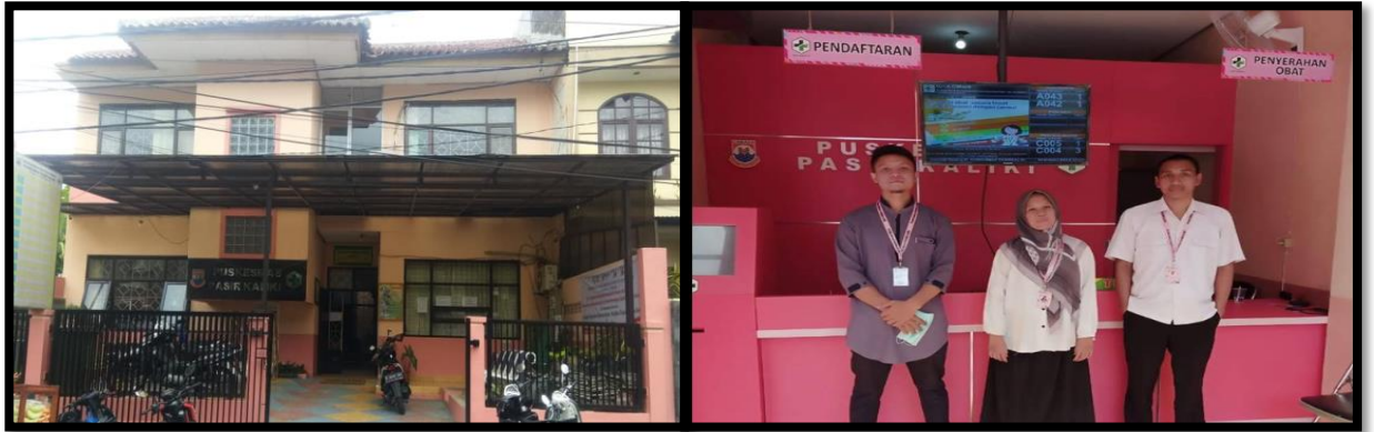
Gambar 33. Bangunan Puskesmas Pasirkaliki
